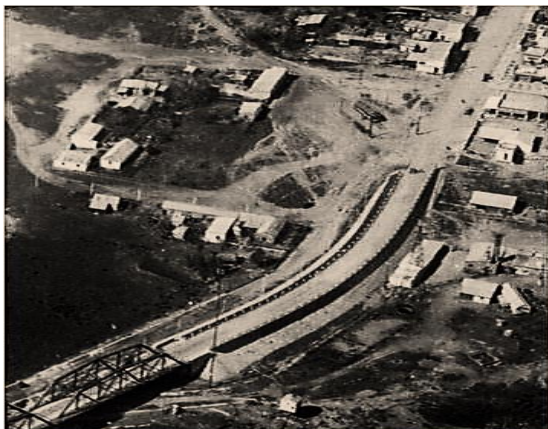
Foto: Ver a la Der. antes del puente, la construcción primera que apunta al río, era la antigua casilla de la guardia española. Hoy en el lugar existe una "L". (Archivo I.M.)
